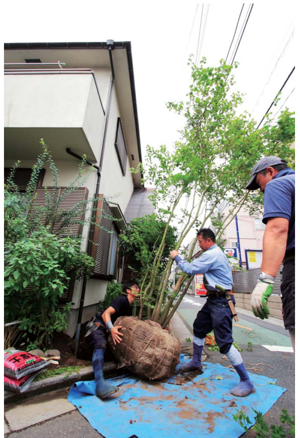
写真9 緑化施工の様子
